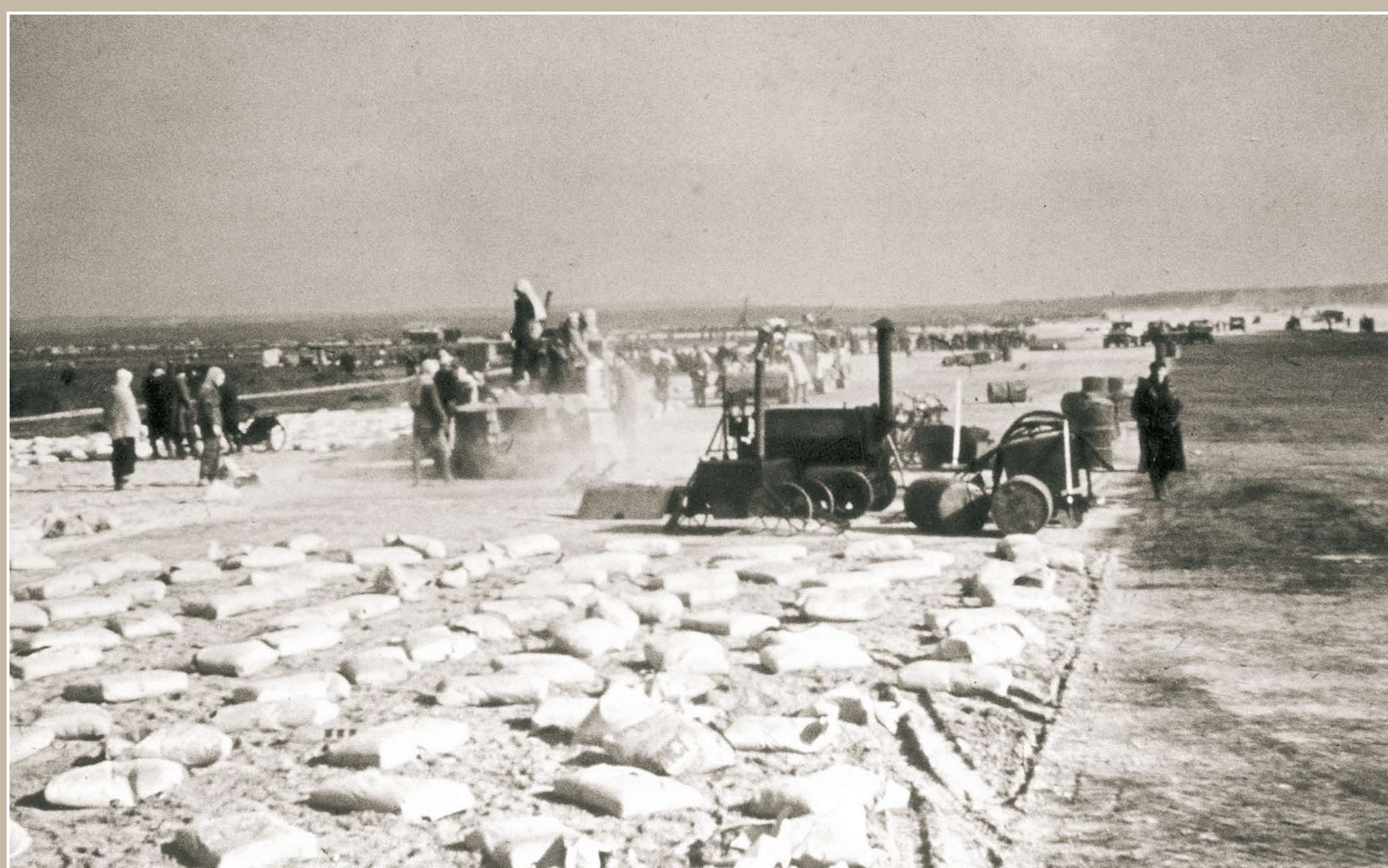
Bouw startbaan winter 1940 | Startbahnbau Winter 1940
