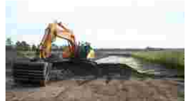
Verwijderen bovenlaag Reigersbroek
